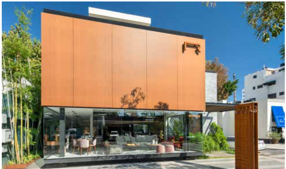
PHOTO: ARQ. FRANCISCO MANOSALVAS · ARCHITECT: PATRICIA SENCIÓN
